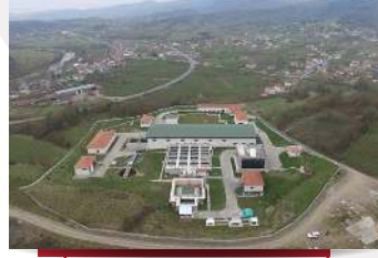
ZONGULDAK DSI TERFİ MERKEZİ (MCC Panoları)
