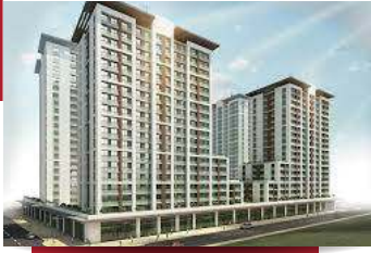
TORKAM FİKİRTEPE PROJESİ (Saha Dağıtım Panoları)
