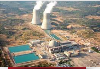
AKKUYU NÜKLEER SANTRAL (Saha Dağıtım Panoları)
